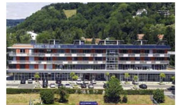
Mittelfristig sollen 20.000 m 2 Kollektorenfläche – wie hier auf einer Dachfläche in der Theodor-Körner Straße – nutzbar gemacht werden.
