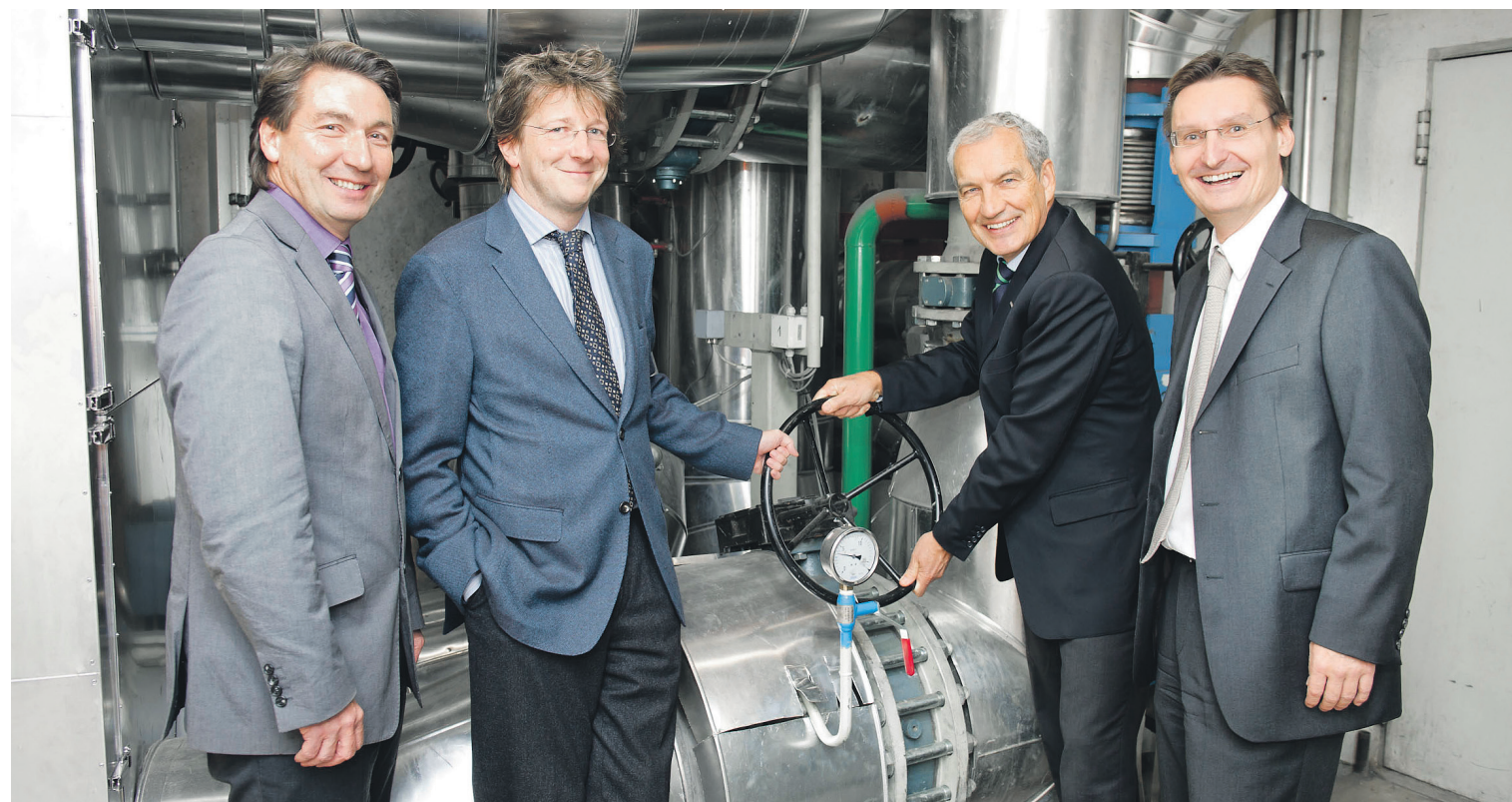
♦ Die Geschäftsführer der Marienhütte, Dipl.-Ing. Helmut Fohringer und Dr. Markus Ritter und der Energie Graz Dr. Rudolf Steiner und Dr. Gert Heigl in der Pumpstation
